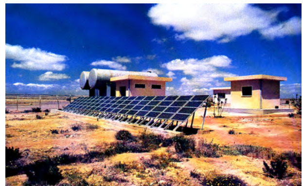
Pumpstation in Jordanien, betrieben mit Solarzellen
