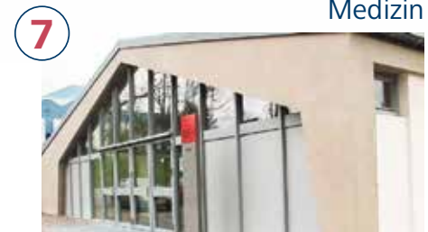
Aula, Gebäude A3 3
