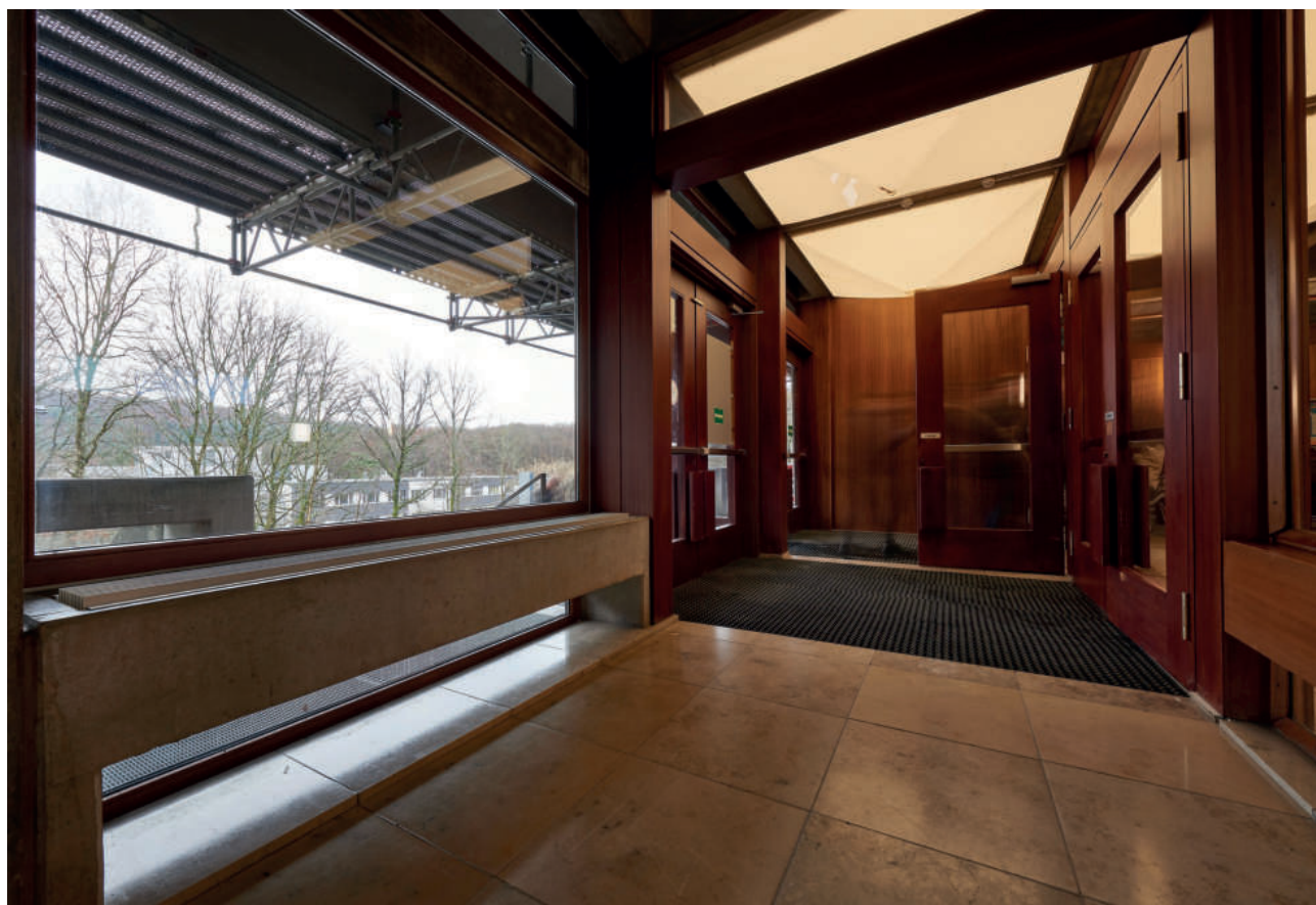
Fig.24 Hintereingang der Mensa mit Schutzgerüst 2018 © Marco Kany
