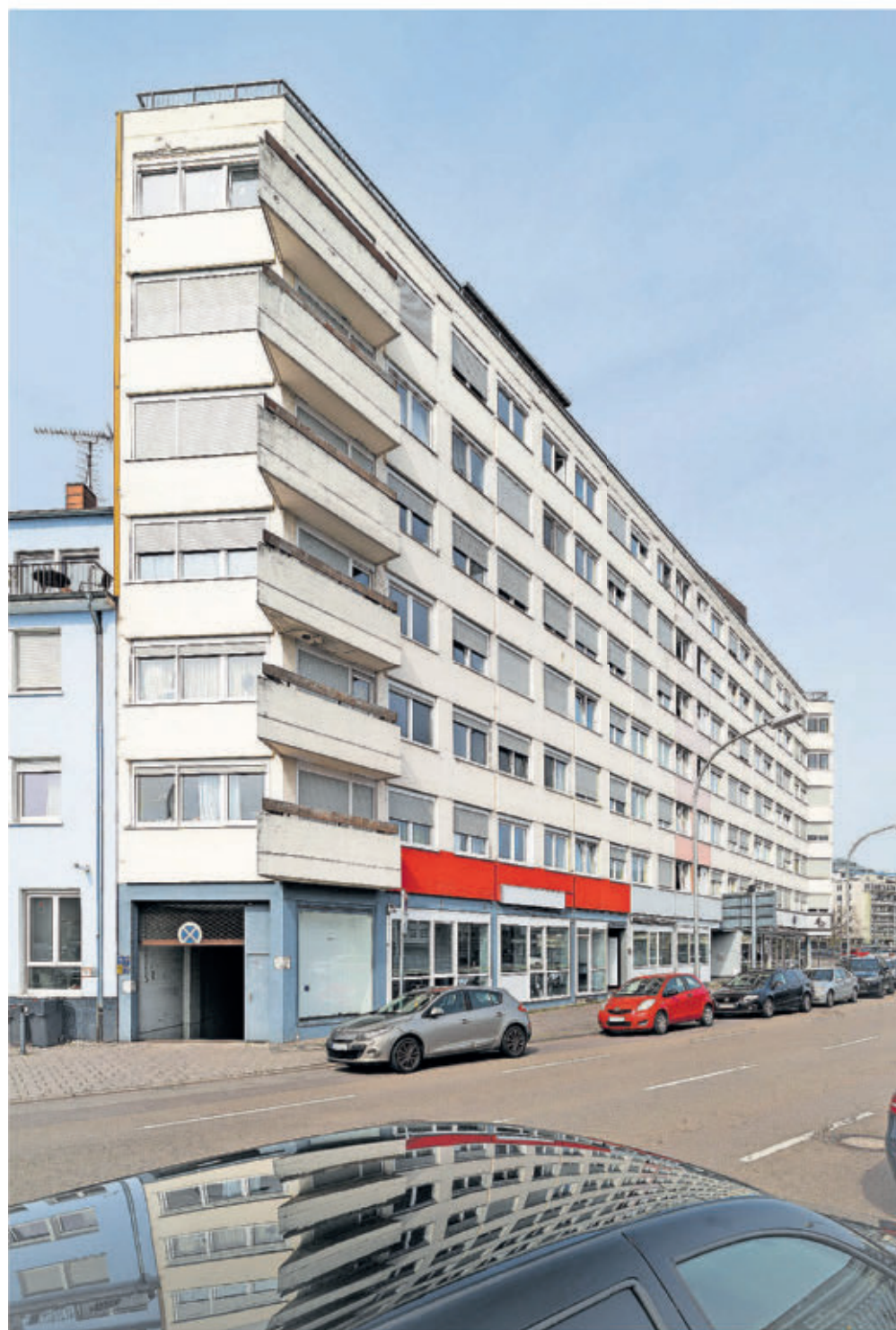
Das Studierendenwohnheim Cusanus-Haus an der Saarbrücker Saarferstraße: Da seine anstehende brandschutztechnische Erneuerung unkalkulierbare Folgekosten nach sich ziehen würde, muss der Trägerverein nun schweren Herzens die Notbremse ziehen.
