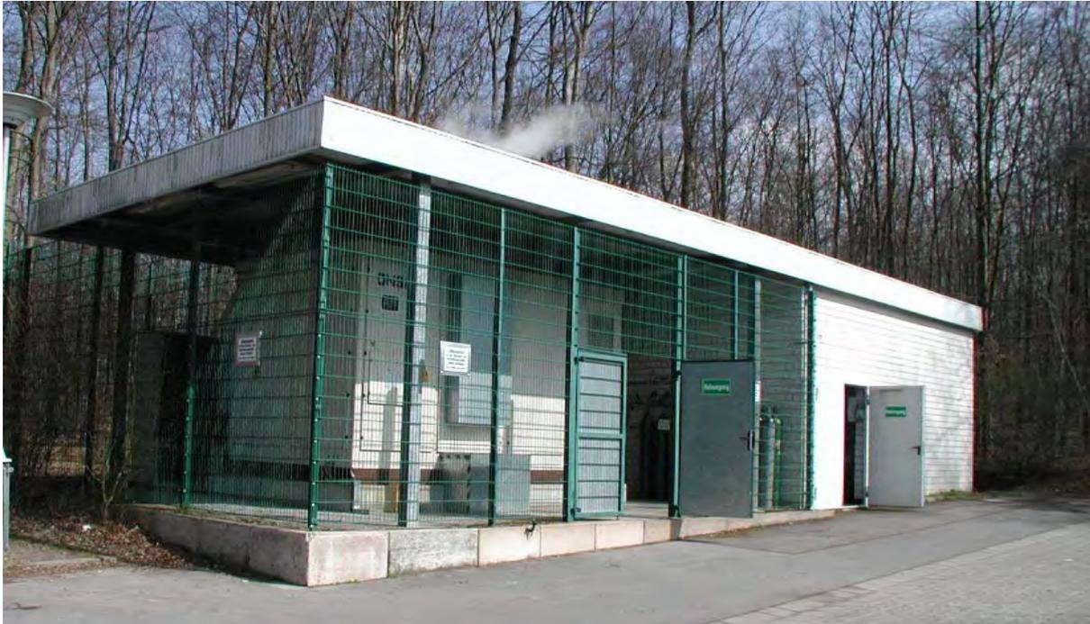
Abb. 69: PAFC-Brennstoffzelle 200 kW<sub>el</sub>, Saarbrücken Nachtweide
