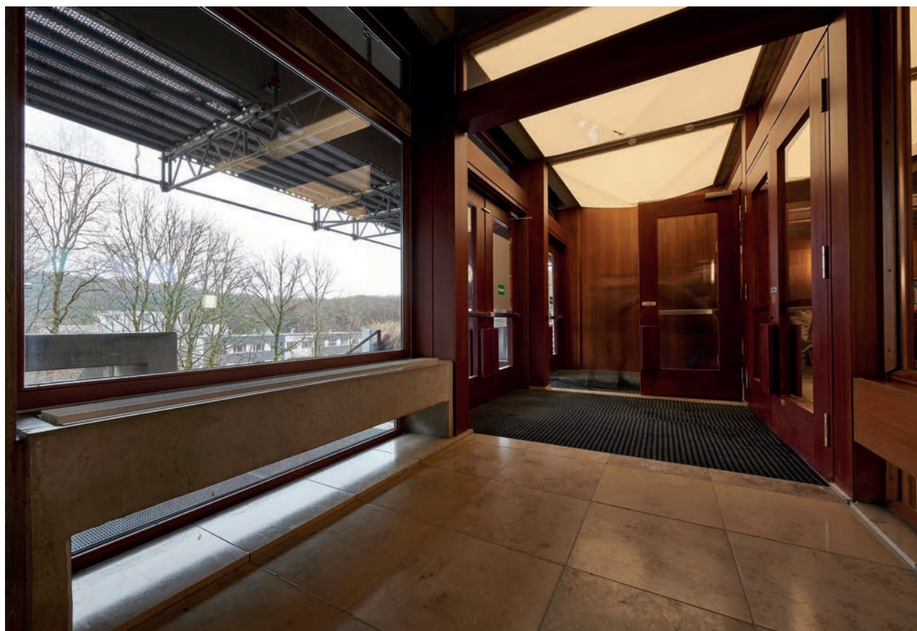
Fig.24 Hintereingang der Mensa mit Schutzgerüst 2018 © Marco Kany
