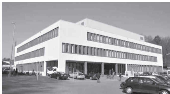
Neues Gebäude 77 seit 2011
