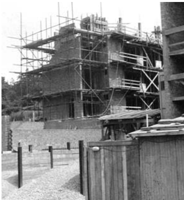
Das Wohnheim im Rohbau
