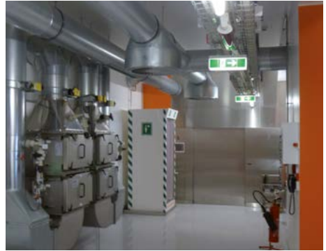
Abb. 4 Bau für S3-Experimente
